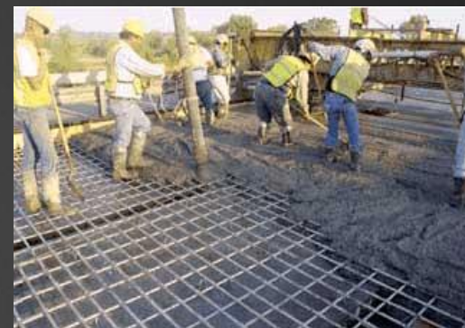
Рис.3. Строительство моста, Канада
